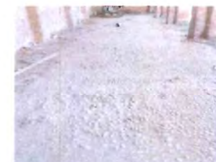
Particolare pavimentazione in ACCIOTTOLATO ESISTENTE (campate da 1 a 4)
